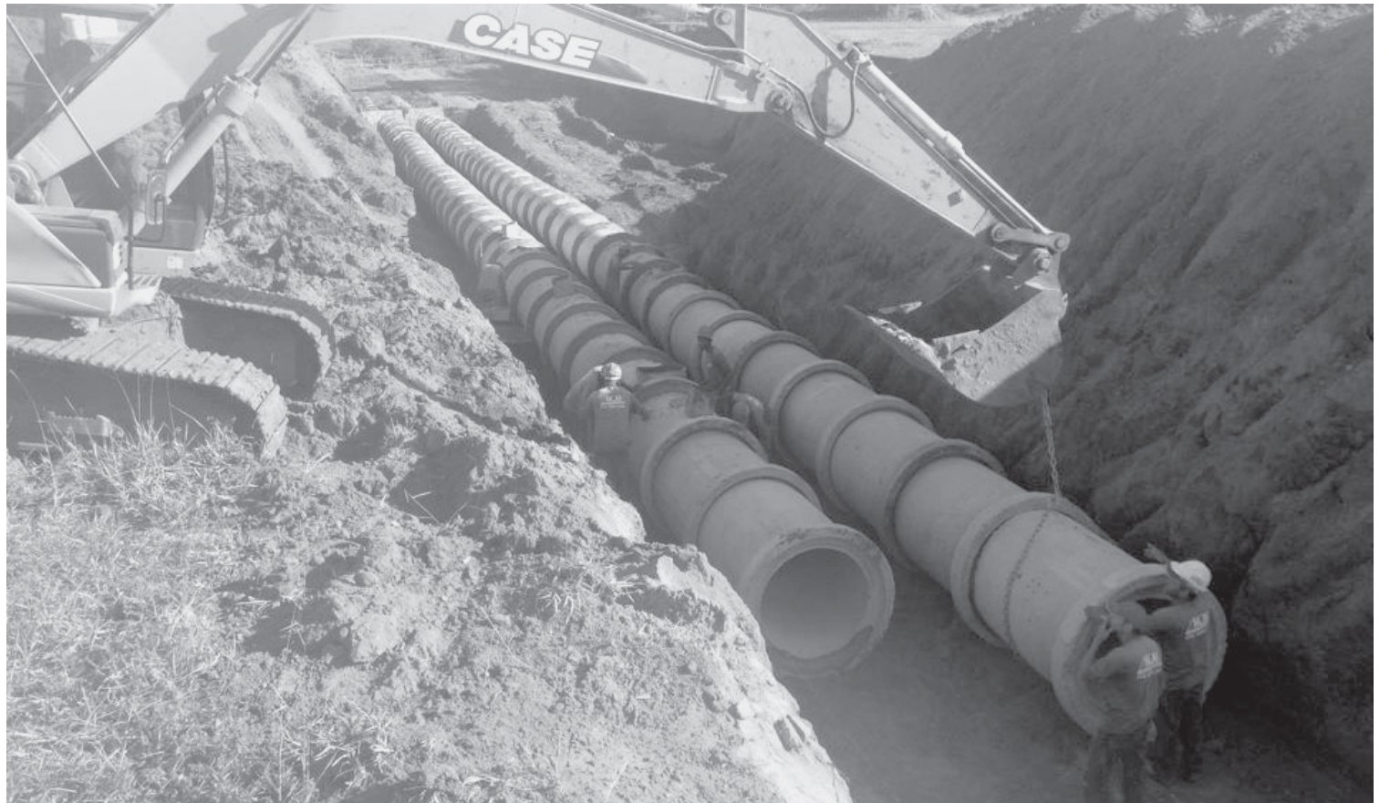
Infraestrutura que fica escondida abaixo da superfície é fundamental para drenagem da água das chuvas e maior durabilidade do asfalto
