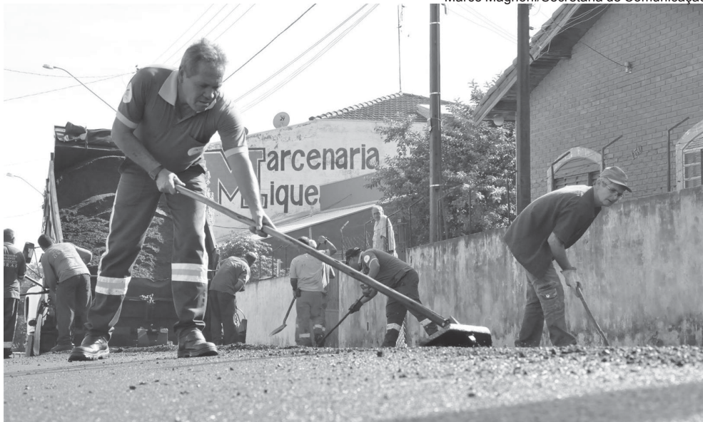
Funcionários da Secretaria de Obras em recape na Rua Benedito Pires de Almeida
