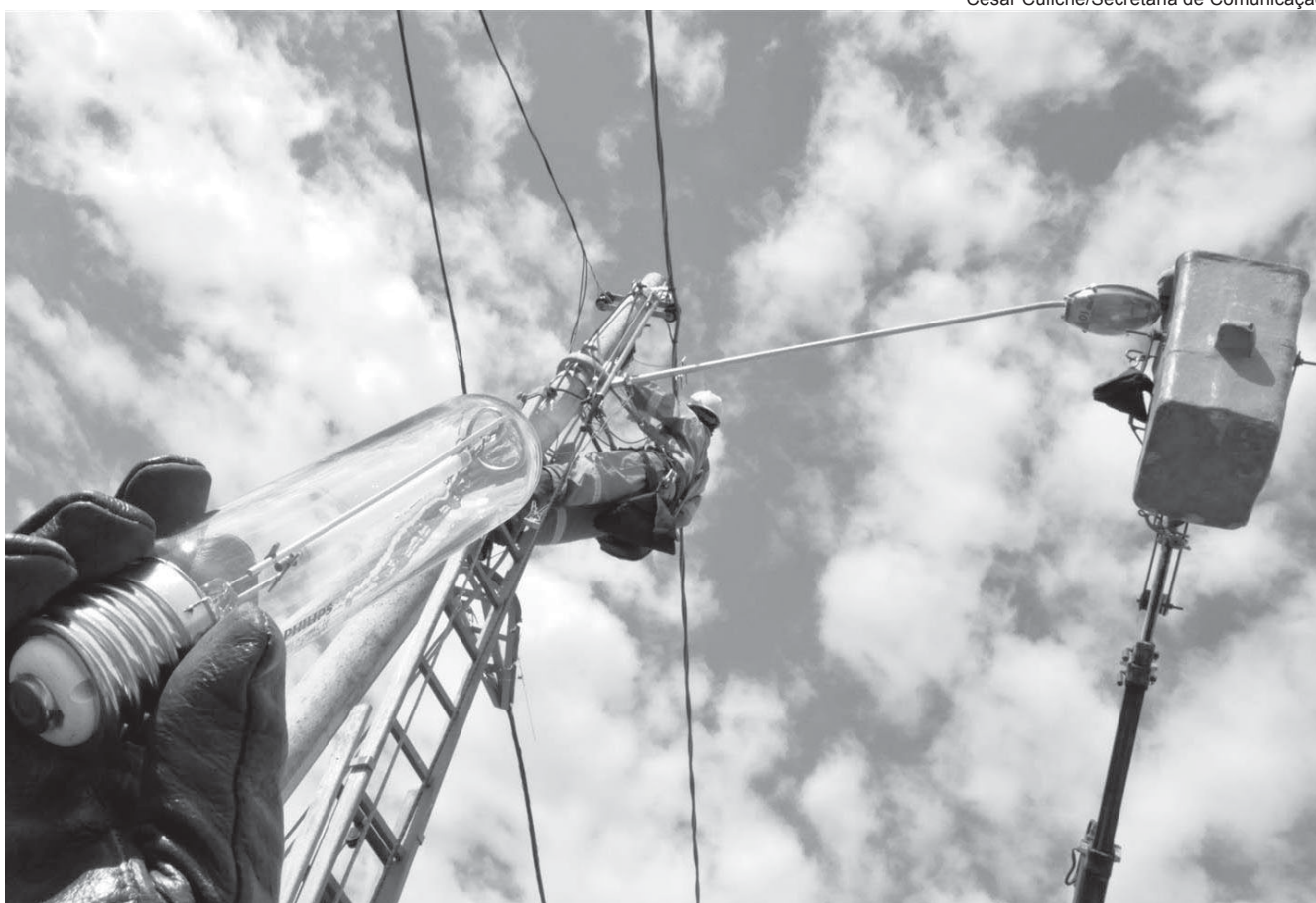
Estão sendo instalados 201 novos conjuntos de iluminação; demanda do Balcão da Cidadania
