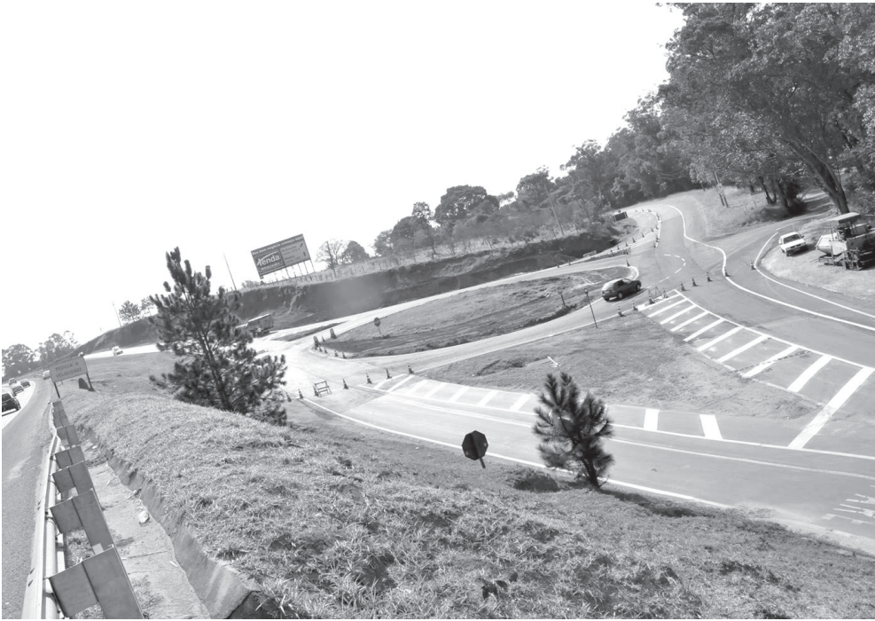
Obras iniciais foram realizadas no entroncamento com a Av. Itália e Marechal Rondon
