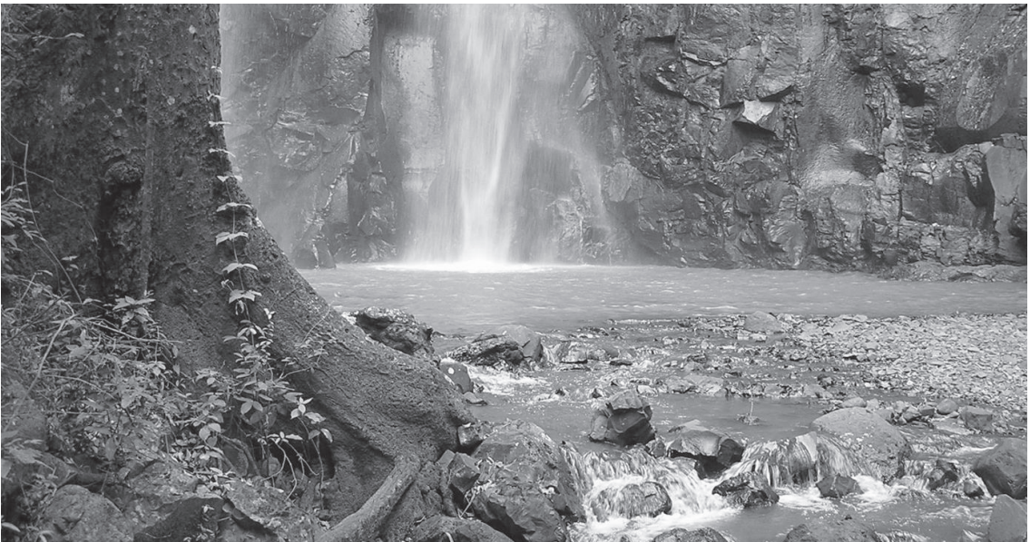
Após diagnóstico, Poder Público deve licitar obras de readequação do local
