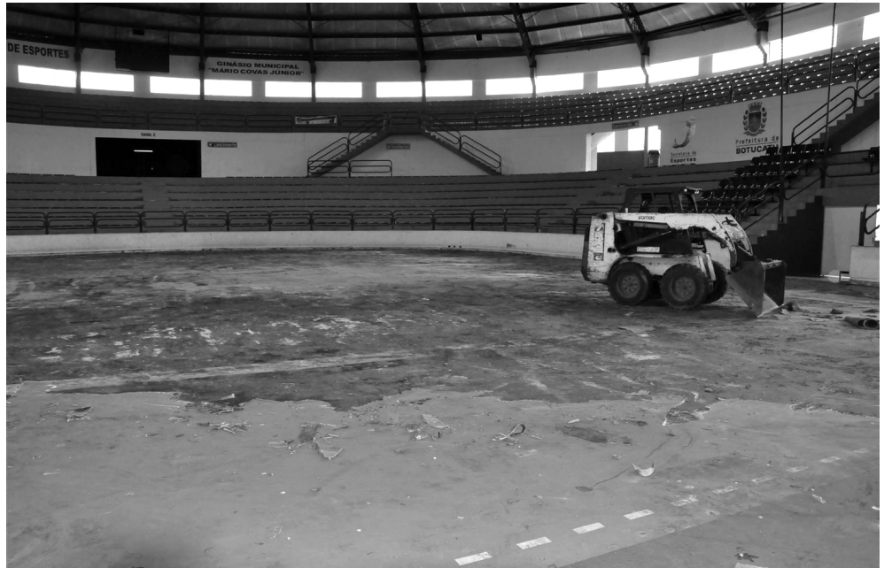
Piso de madeira é retirado para aplicação de material emborrachado
