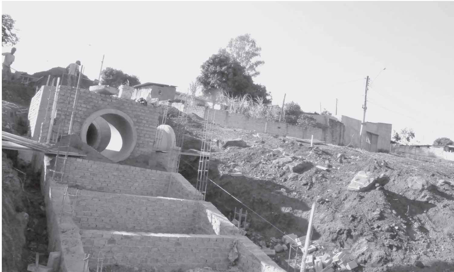
Infraestrutura de drenagem em construção no Monte Mor; serviço é necessário para que futura pavimentação tenha maior durabilidade
