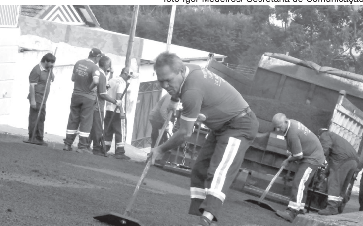
Ruas como Mirabeau Camargo Pacheco já receberam novo asfalto
