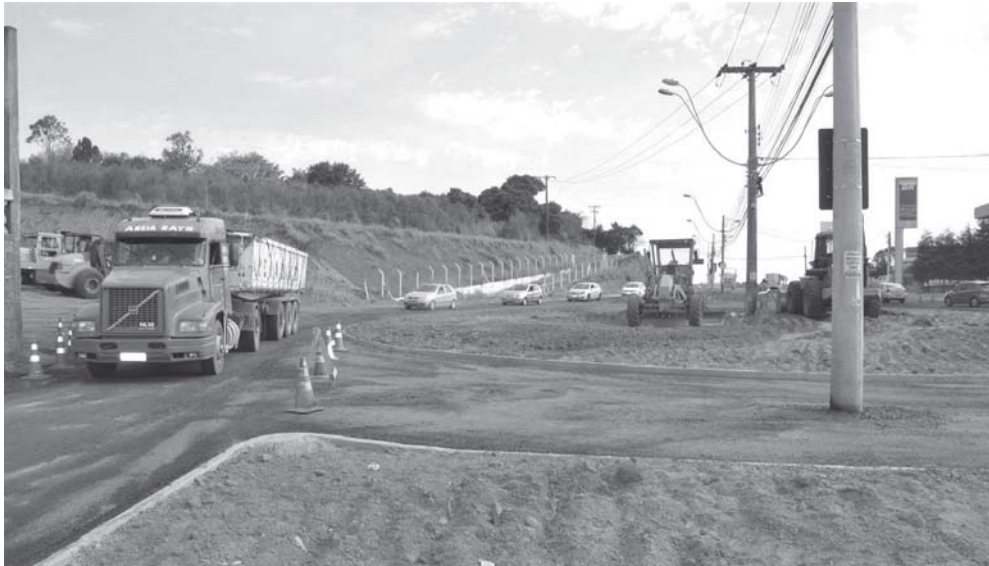
Rotatória na avenida está em fase final de obras
