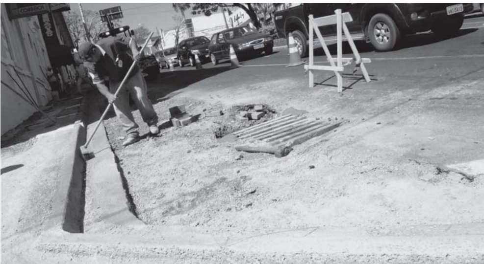
Espaço em construção auxiliará carga e descarga para comércios e serviços
