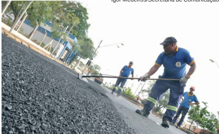
Previsão é utilizar mais de 1.300 toneladas de massa asfáltica
