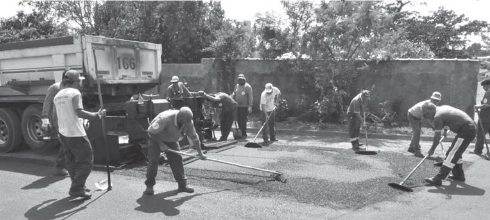
Equipe da Secretaria de Obras em serviço de pavimentação na Rua Jayme Carnietto
