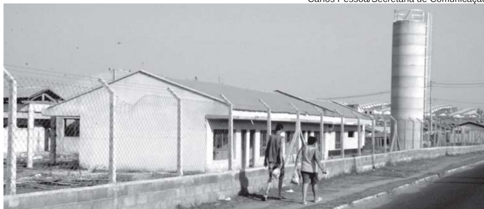
Obra tem cerca de 60% dos serviços concluídos
