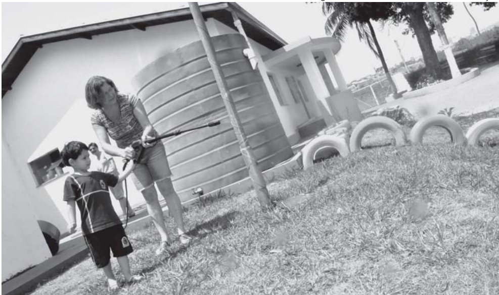
Sistema capta água que cai na calha e armazena-a para serviços de limpeza e irrigação
