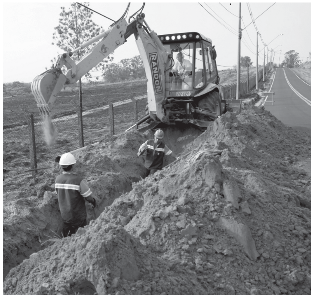
Equipe da Sabesp assenta tubulação na Gastão dal Farra
