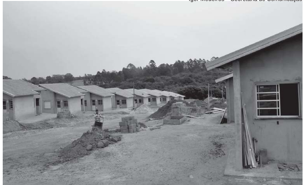
Residencial Nova Esperança, com 71 moradias, está em construção no Distrito de Rubião Júnior
