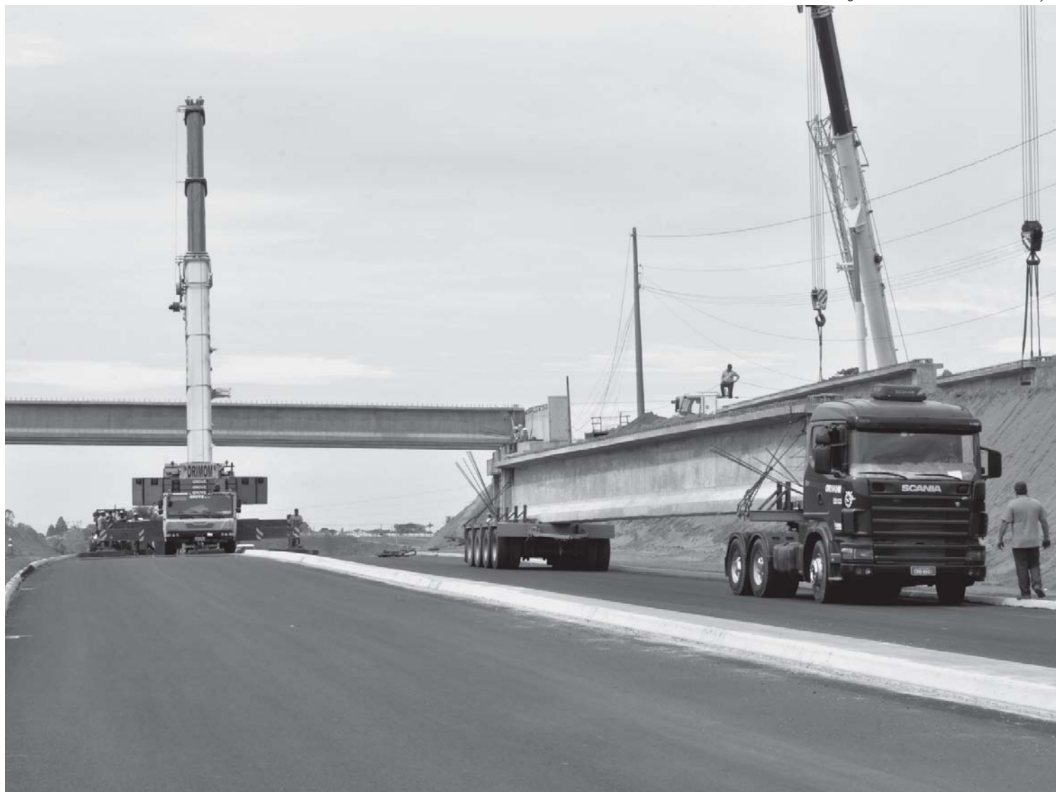
Caminhões e guindastes ajudam na colocação das vigas do viaduto que transpassa a rodovia e irá melhorar acessos à Unesp, Distrito Industrial e bairros do entorno
