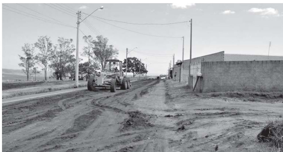
Máquinas da Prefeitura já preparam base das ruas do bairro
