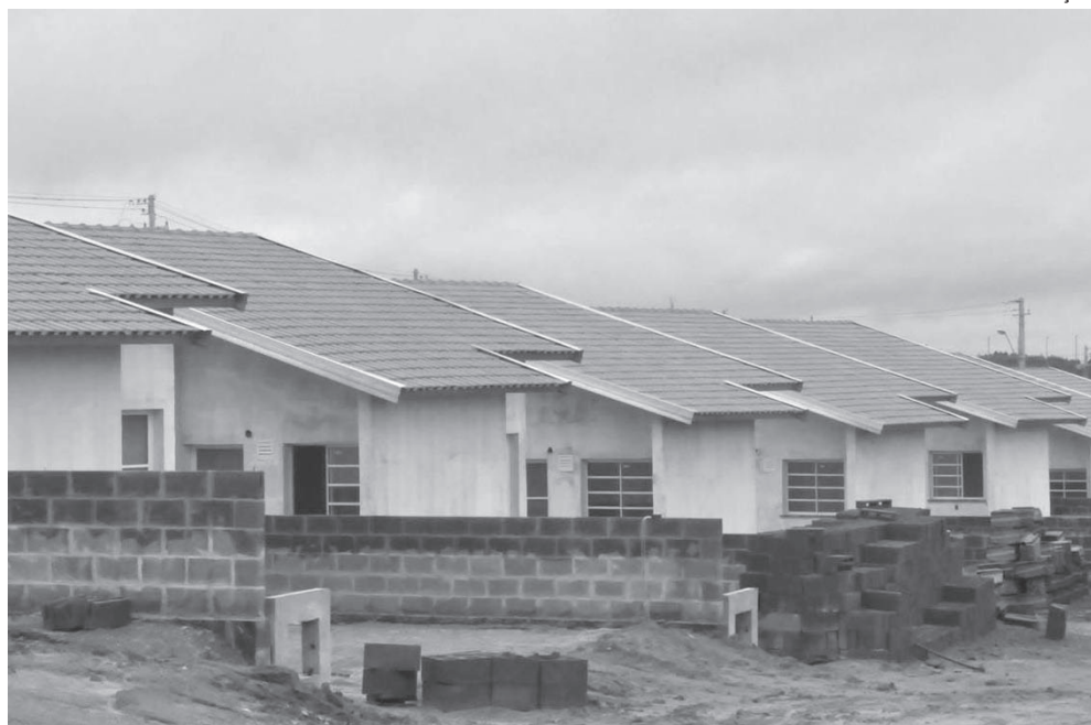
Casas do conjunto Nova Esperança, em Rubião, estão em obras avançadas
