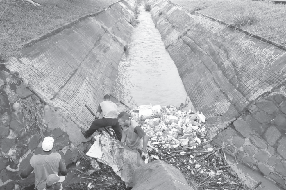
Equipe faz limpeza do Córrego Água Fria, próximo à Rodoviária
