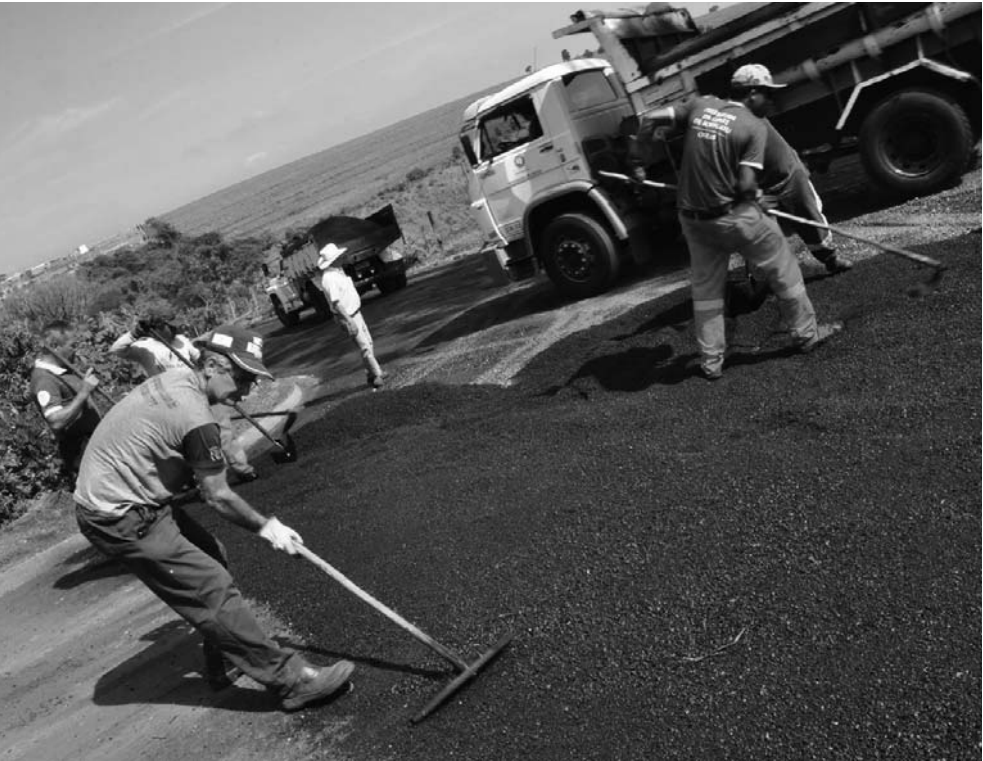
Rua 16, após obras de galeria, recebe pavimentação
