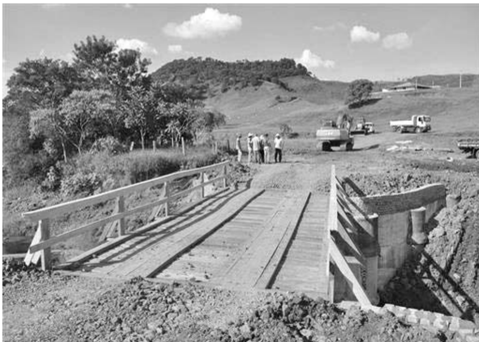
Ponte do Araquá foi recentemente reformada
