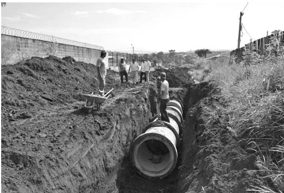
Serão mais de 400 metros de tubulação para captar a água das chuvas na Rua Gregório Pedro Garcia
