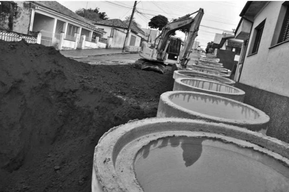
Trabalhos estão concentrados no trecho entre as ruas Galvão Severino e Cruz Pereira
