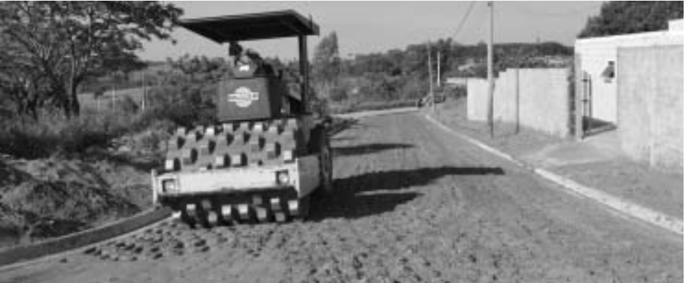
Ruas do Jardim Botucatu estão sendo preparadas com guias e sarjetas antes de receberem asfalto novo
