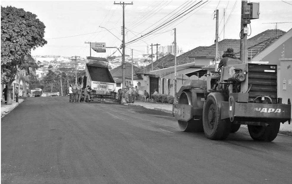
Serviço de pavimentação complementa galeria em construção na Jaguaribe
