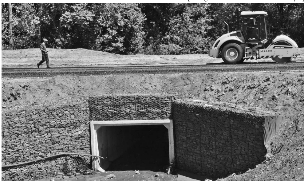
Rua Silvestre Bartoli foi pavimentada após obra de drenagem
