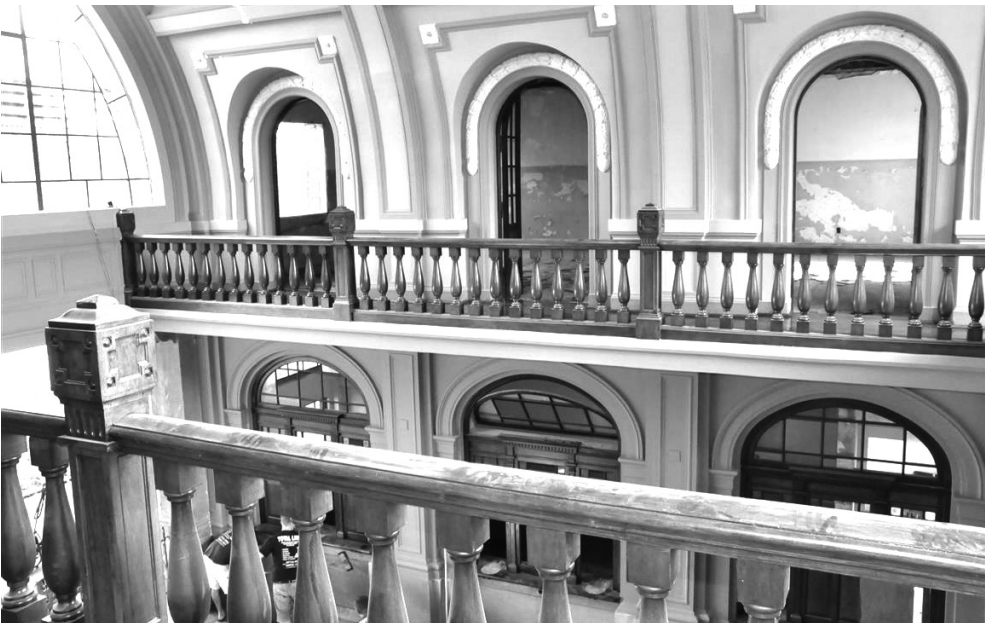
Madeiramento e paredes do saguão principal já foram concluídos
