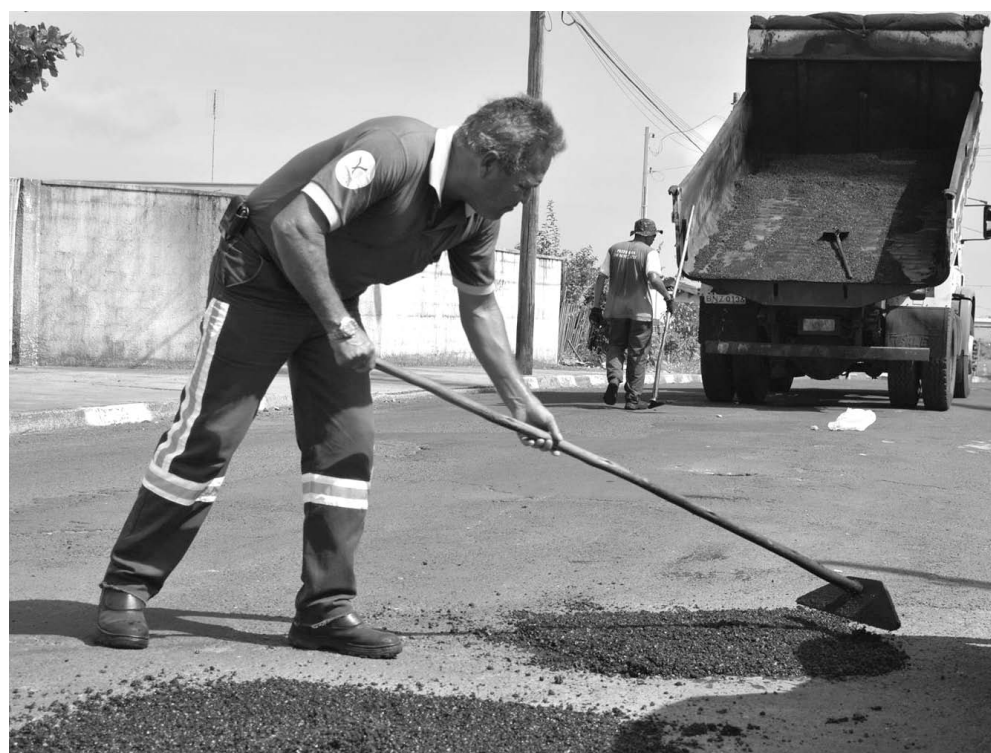
Programa concentrará serviços de infraestrutura e zeladoria como limpeza de bueiros, tapa buracos, capinação de mato alto, entre outros
