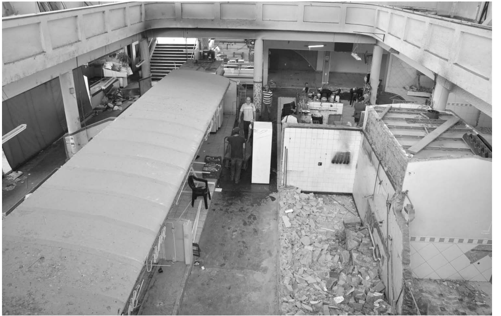
Primeira etapa prevê demolição de paredes, pisos, parte elétrica e hidráulica
