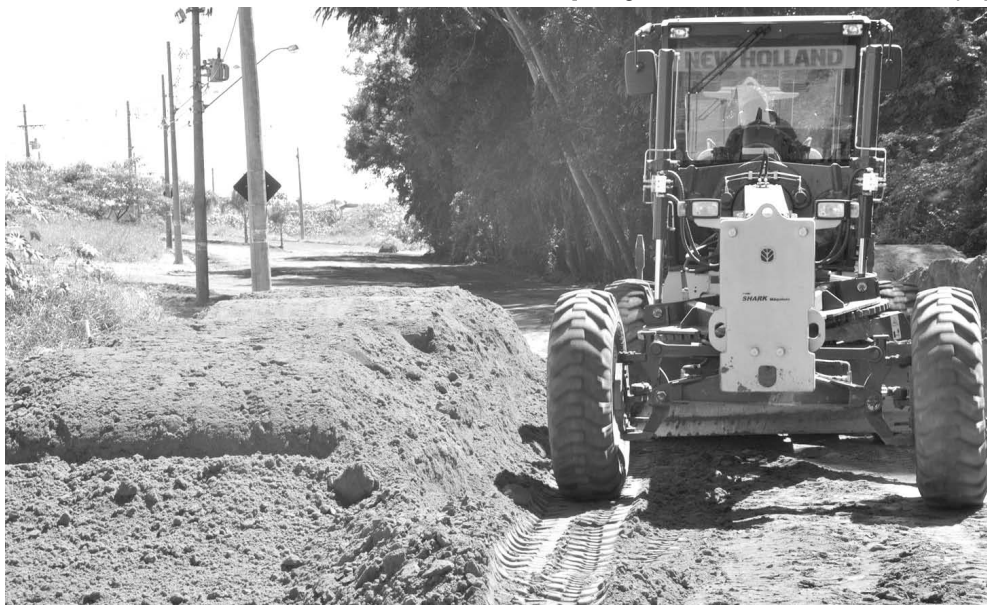
Máquinas da Secretaria de Obras trabalham no alargamento da pista
