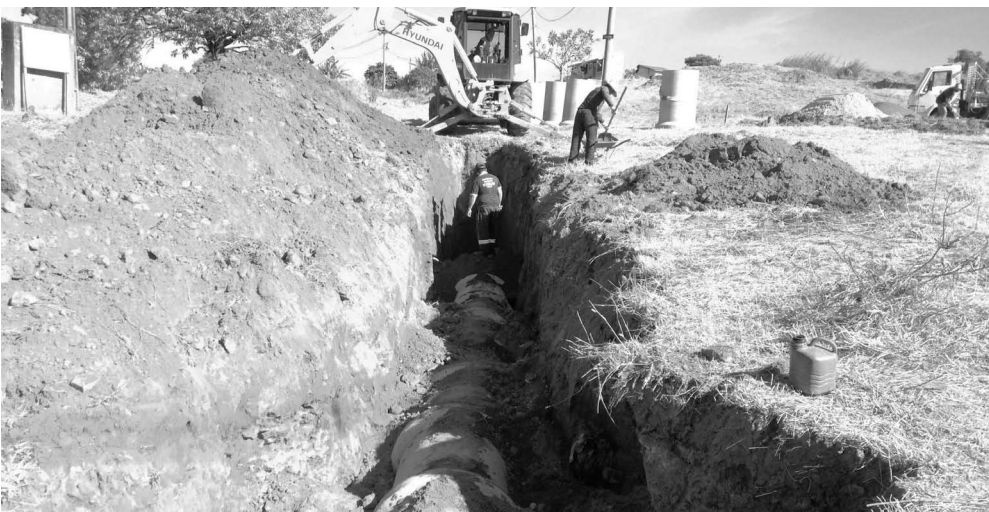
Infraestrutura de drenagem da água das chuvas antecede pavimentação
