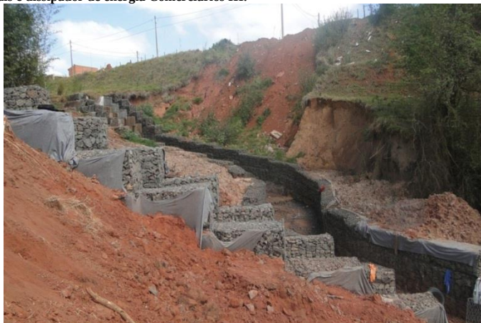
Foto 10 – Galeria de águas pluviais e dissipador de energia Comercários III.
