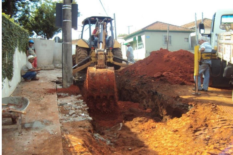
Foto 8. Galeria de águas pluviais Vila Casa Branca.
