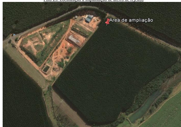
Foto 25. Localização a implantação de aterro de rejeitos
