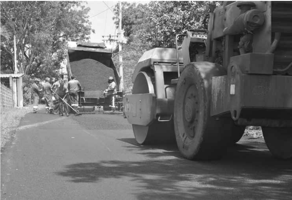
Foram utilizadas mais de 600 toneladas de asfalto para pavimentação de ruas do distrito
