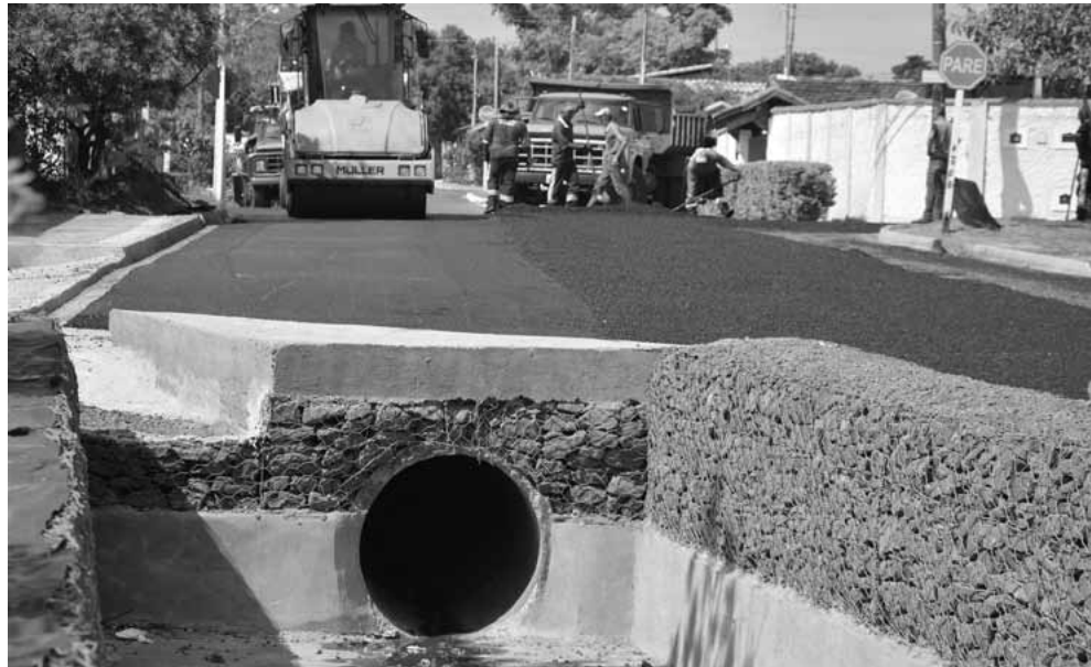
Rua Duque de Caxias recebeu obras de canalização e pavimentação
