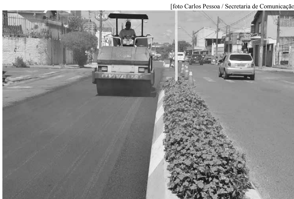
Asfalto começa a dar nova cara à avenida da região Norte
