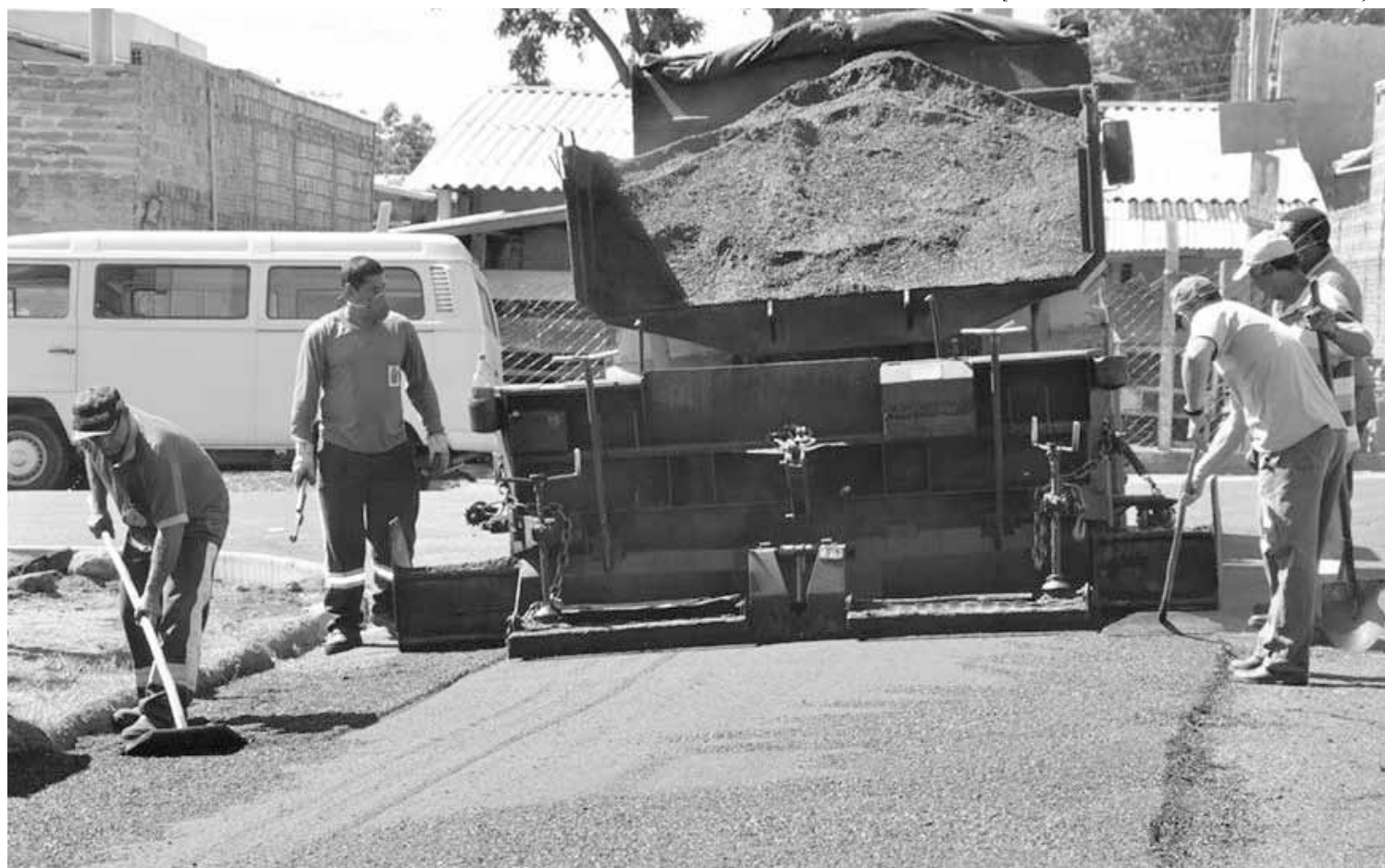
Foram utilizadas mais de 300 toneladas de massa asfáltica em diversas vias do bairro
