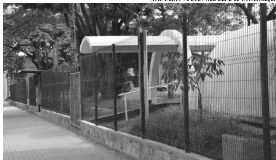
Área externa já conta com nova calçada e alambrado
