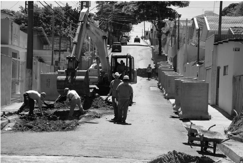
Nesta etapa são implantados mais de 700 metros de tubulações
