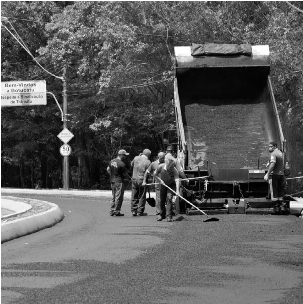
Avenida está sendo urbanizada e contará com iluminação, ciclovias e paisagismo
