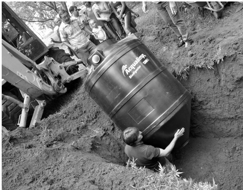
Em Botucatu serão instaladas fossas biodigestoras em 60 propriedades
