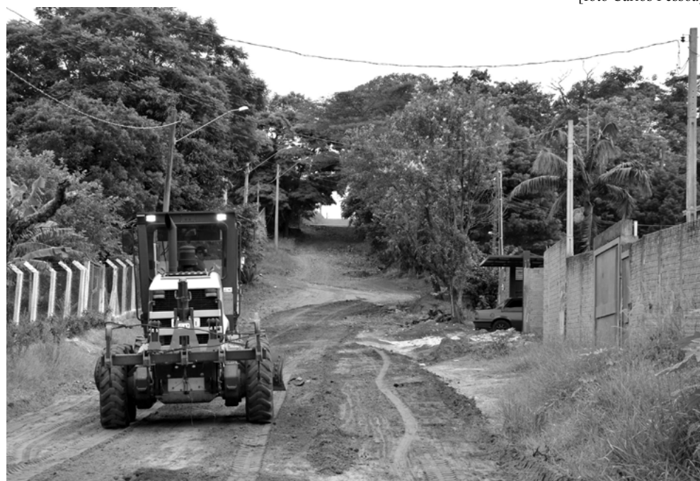
Máquinas fazem manutenção nas ruas de terra do bairro da região sul
