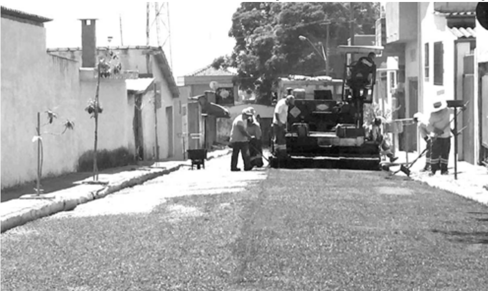
Novo asfalto começa a dar nova cara ao bairro
