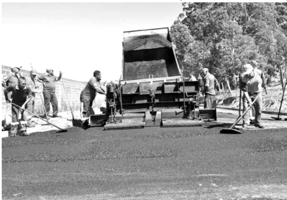
Rua Antonio Martins Filho teve pavimentação concluída
