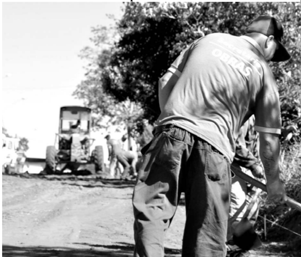
Ruas do bairro da região sul ganham guias e galerias antes da chegada do asfalto
