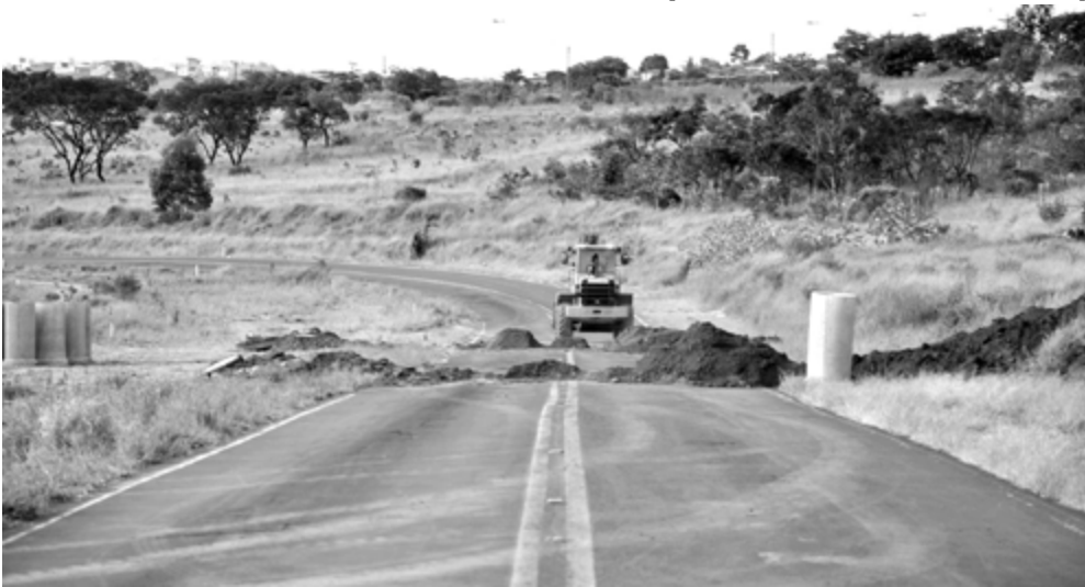
Durante as obras, rodovia segue interditada e com desvios para acesso a bairros da região sul
