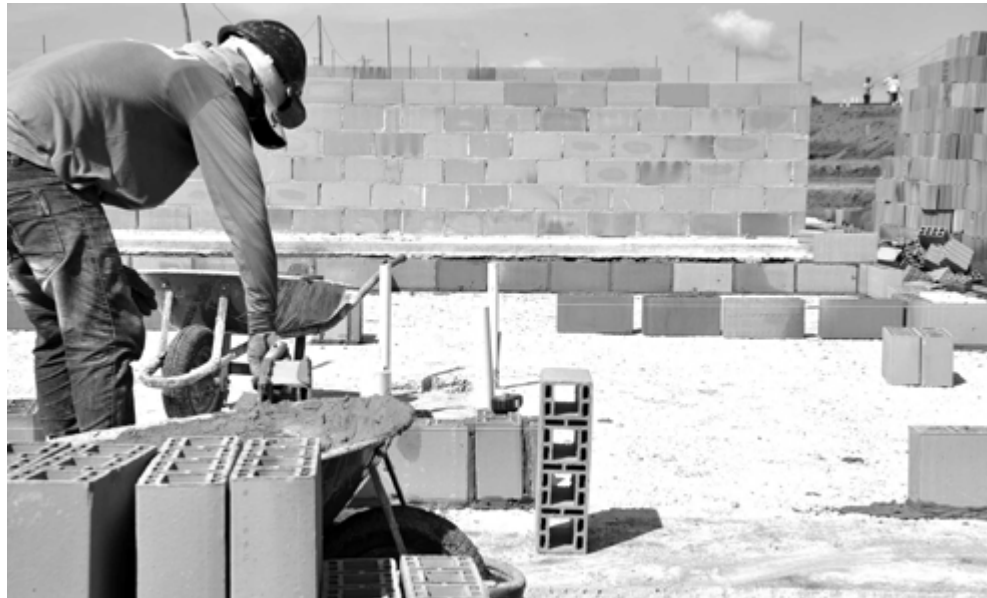
Na área habitacional, 337 casas já começaram a ser construídas na região sul
