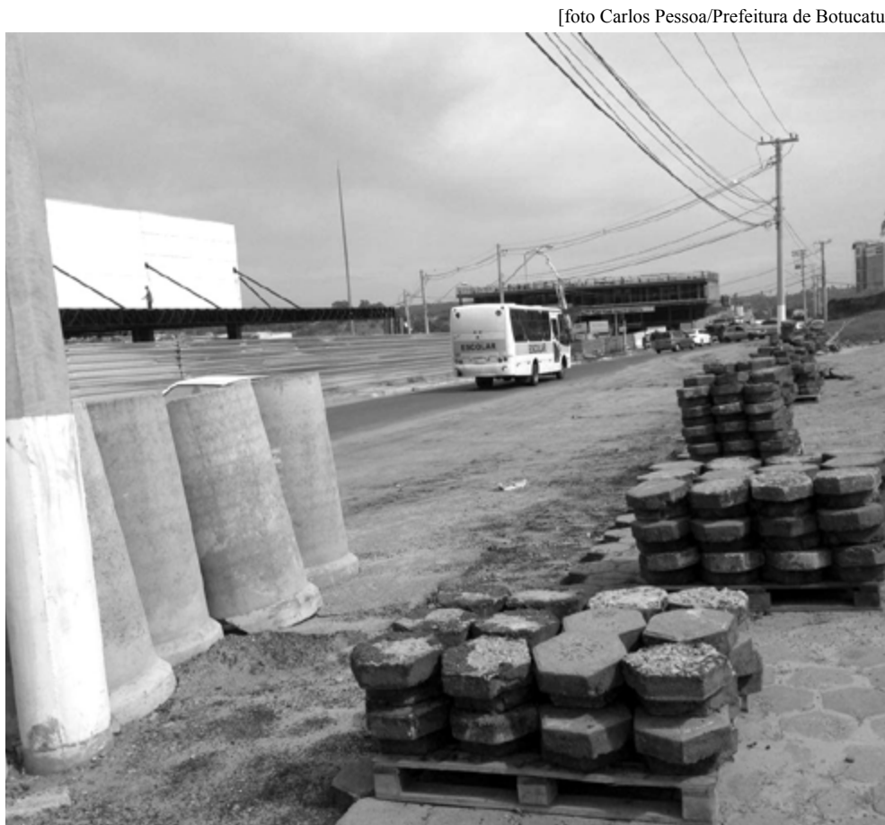
Trecho interditado fica ao lado de futuras instalações de rede de supermercado
