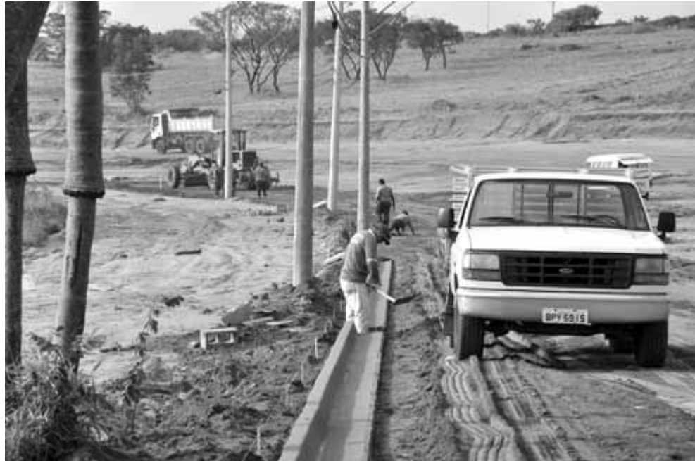
Rodovia de ligação da região sul tem sido demarcada com guias e sarjeta
