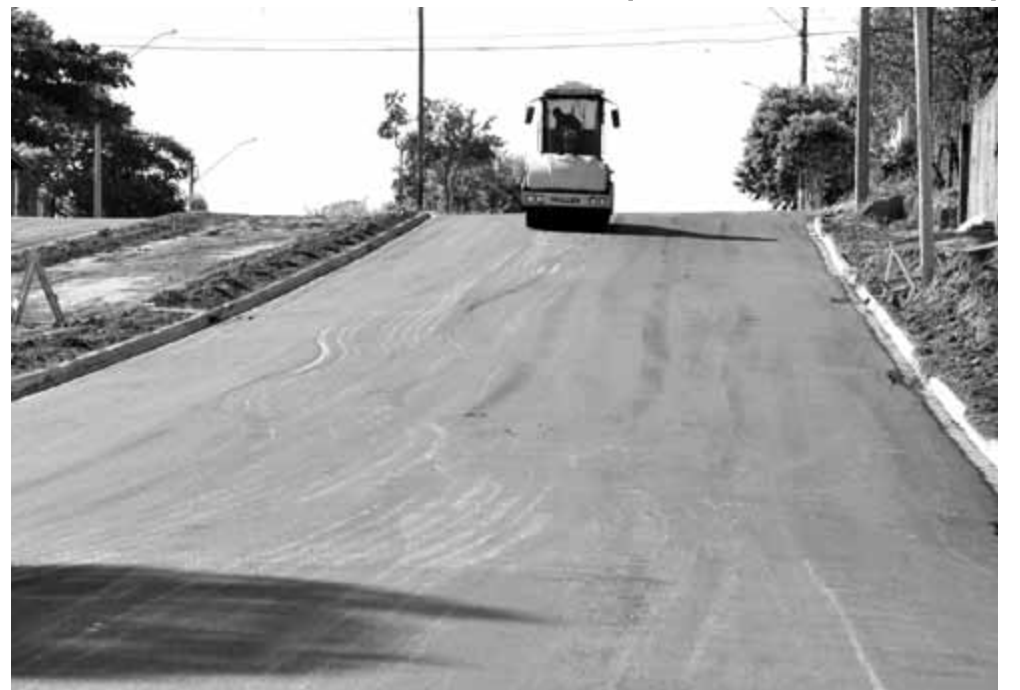
Pavimentação está na Avenida das Primaveras
