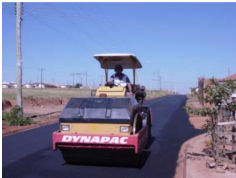
Asfalto da Cohab 5 já está pronto
