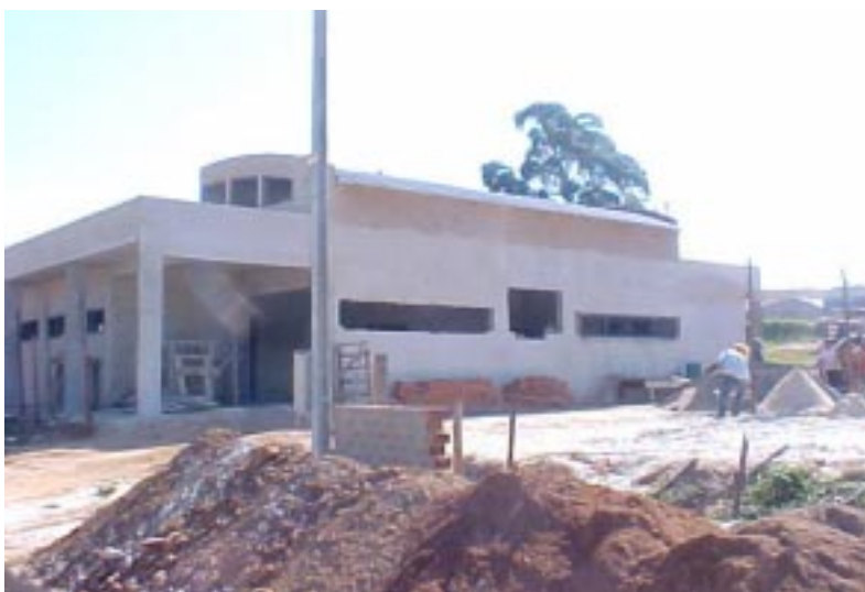
Unidade do PSF em construção no Monte Mor
