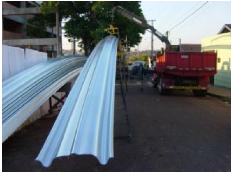
Ginásio está sendo coberto
