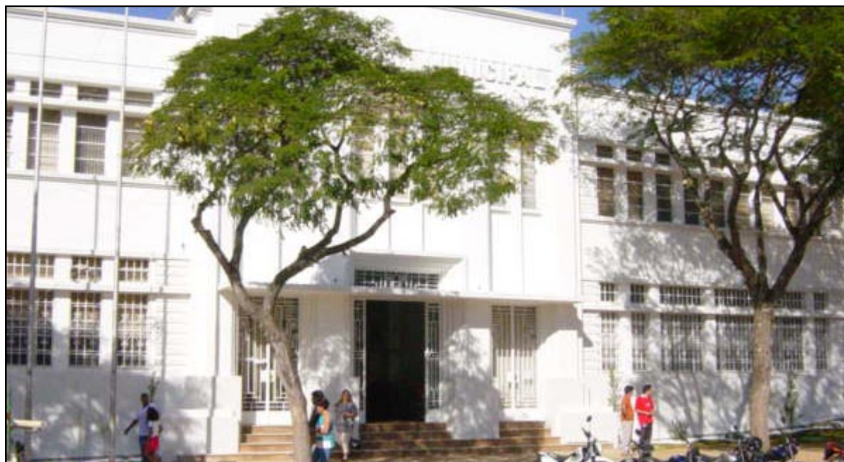
Prédio da Prefeitura ganhou nova praça e uma nova pintura
