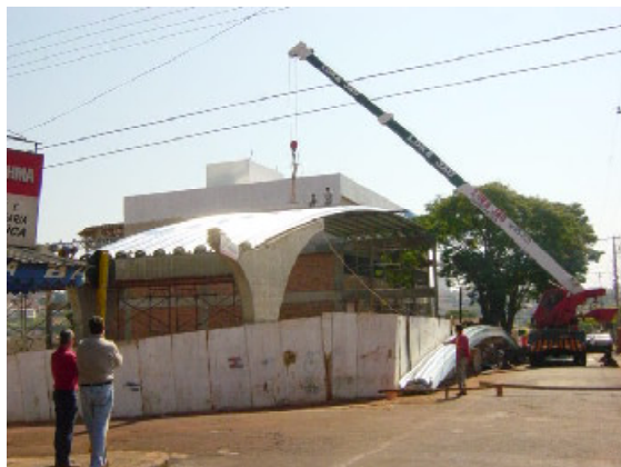
Cobertura do ginásio foi concluída na semana passada
