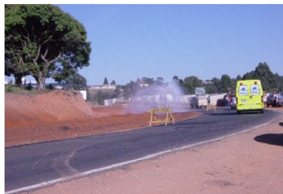
Obra foi iniciada no final de semana
