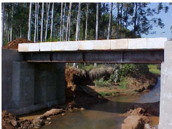
Ponte já está liberada para a comunidade
