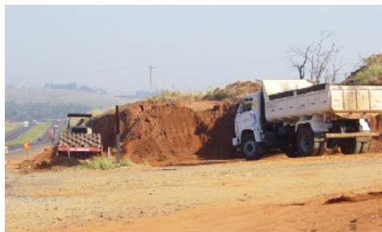
Obras têm 30 dias para serem concluídas
