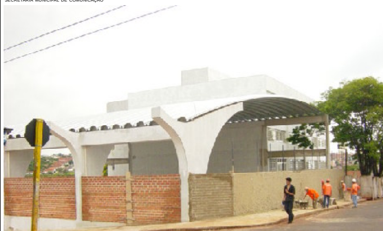
Obras de ampliação da Escola João Maria de Araújo entram na fase final
