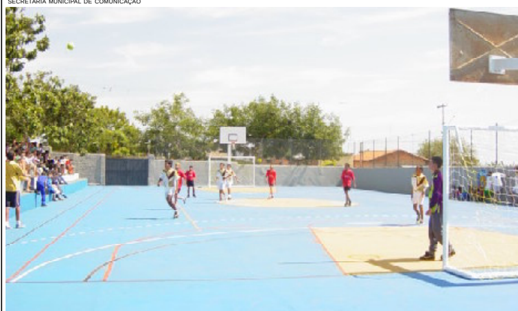
Quadra do projeto Vida Nova, no Jardim Vista Linda, reformado recentemente pela Prefeitura
