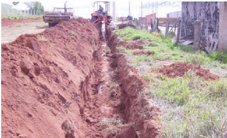
Obra no Distrito Industrial 3 deverá estar concluída na próxima semana
