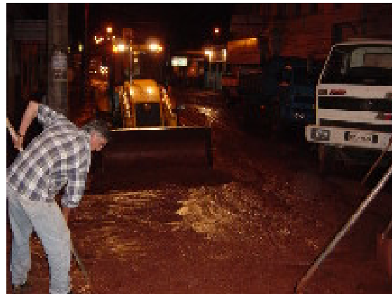
Trabalhos prosseguiram à noite
