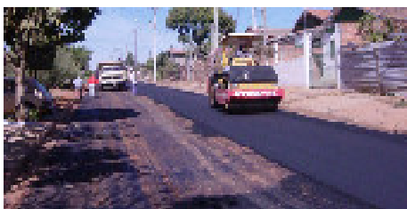
Jardim Aeroporto sendo asfaltado
