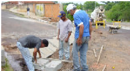
Canaletas (concreto): cruzamento da Cel. Fonseca
