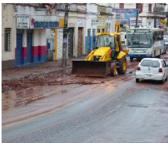
Mais de 100 homens trabalharam nos reparos
