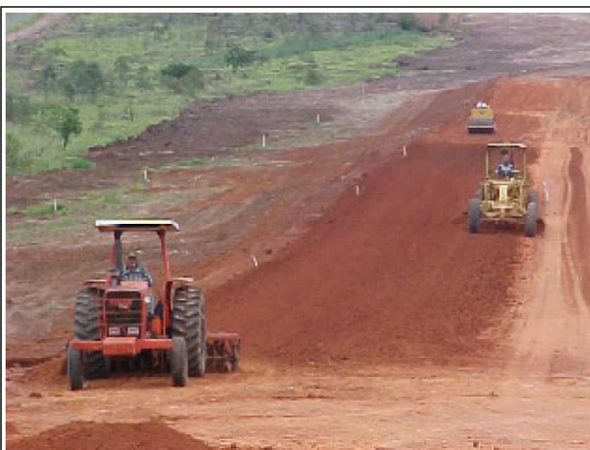
Obra da avenida Alcides Cagliari, que está ganhando um novo traçado. Apesar das chuvas que tem castigado a nossa região, o novo traçado deverá ser entregue no mês que vem. O desvio está sendo necessário devido a ampliação da Indústria Aeronáutica Neiva, que deverá gerar 1.000 novos empregos.
