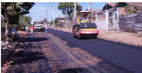
Jardim Aeroporto sendo asfaltado
