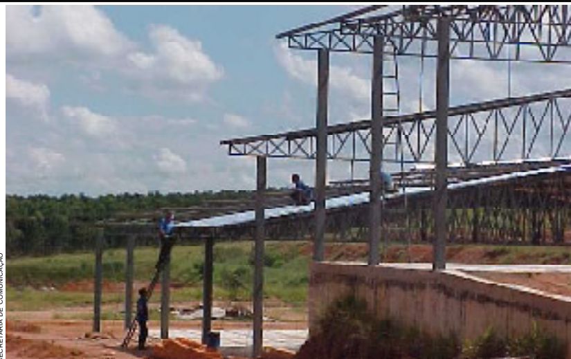
Obras na Usina de Reciclagem seguem em ritmo acelerado
