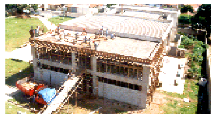
Reforma da Escola do Jardim Flamboyant
