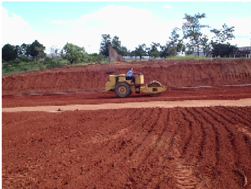
Máquinas da Prefeitura fazem a compactação da terra no novo traçado da avenida
