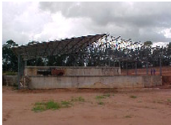
Usina ficará instalada em um prédio com estrutura metálica
