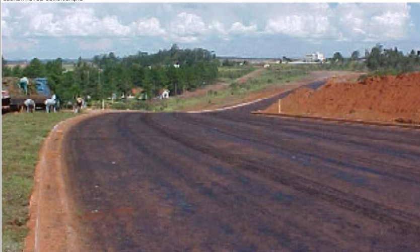
Avenida Alcides Cagliari recebe massa alfáltica
