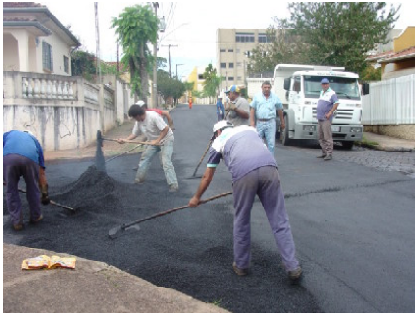
Funcionários da Prefeitura espalham a massa asfáltica
